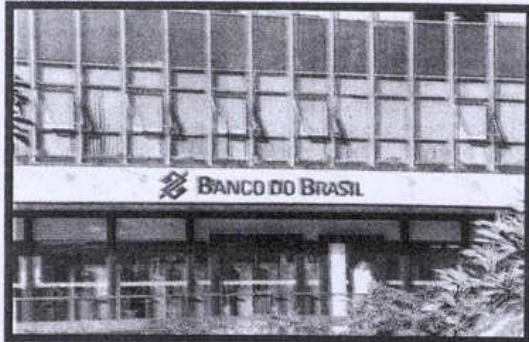
NOVO SISTEMA ESTÁ SENDO EXECUTADO NA AGÊNCIA DA 515 NORTE
